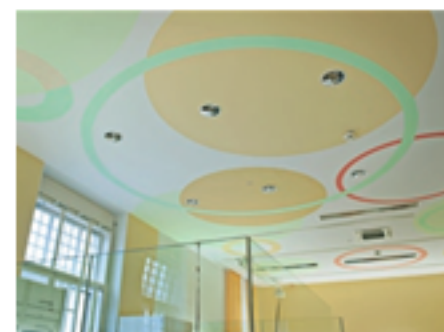
Abb. 5: Die Decken in den Behandlungs- und Patientenzimmern wurden ansprechend farbig gestaltet, wobei die zahlreichen technischen Einrichtungen optisch integriert wurden.
